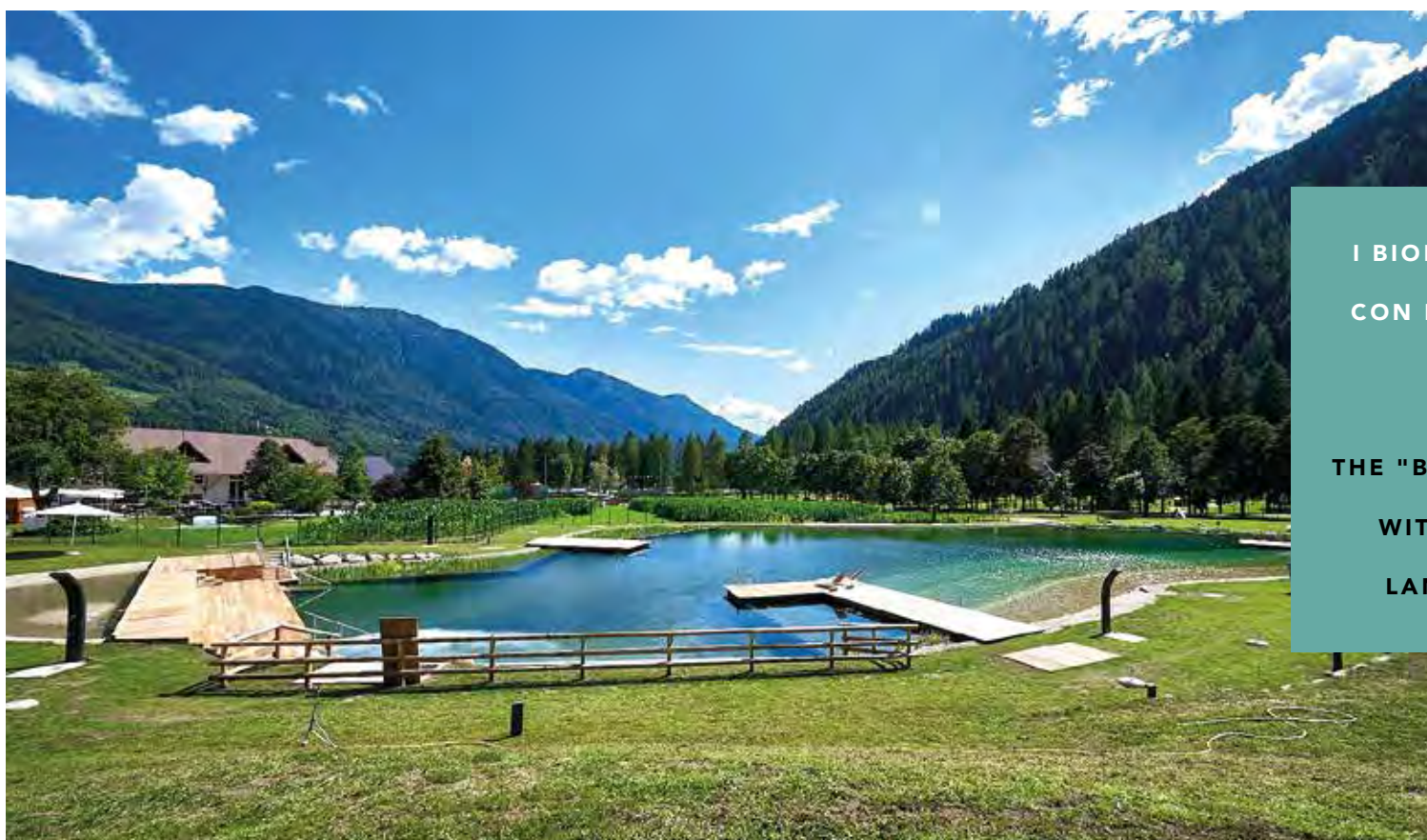
Alcuni scorci del laghetto d'acqua dolce depurato con piante e ghiaia e l'area dove avviene la fitodepurazione. Views of the fresh-water lake filtered by using plants and gravel and the phytodepurazione area. (P: Bisti)
